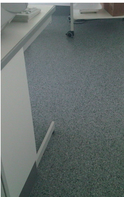
Mit SYSBO+ sanierte Fuge
