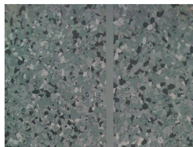
sanierte Fuge
